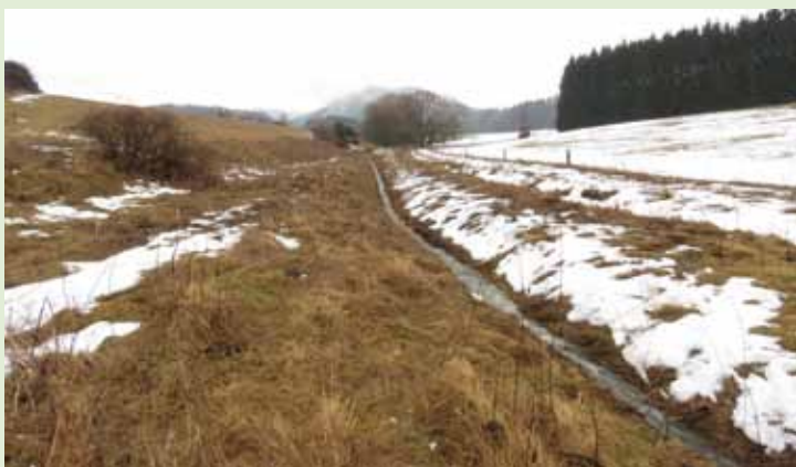
Obrázek 5: Odvodnění krajiny zahloubením, narovnáním a opevněním toku ve dně žlabovkami – pramenná oblast Hrnčířského potoka. Těmito úpravami se urychluje odtok vody z krajiny, což na jedné straně znamená sucho, při přívalových pak bleskové povodně. Sucho umocňuje podzemní drenáž na okolních pozemcích na desítkách ha. Ještě před 30 roky tekla voda v toku po celý rok. Nyní větší část roku neteče vůbec. Jaro 2017.
