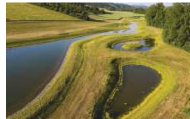
Obrázek 31: Revitalizační opatření na pravém břehu potoka Holomňa v k.ú. Drslavice, Pobočka Uherské Hradiště, Zlínský kraj. Rok realizace 2019 – 2020, náklady na realizaci 27 688 663 Kč, zdroj financování PRV 2014 – 2020.
