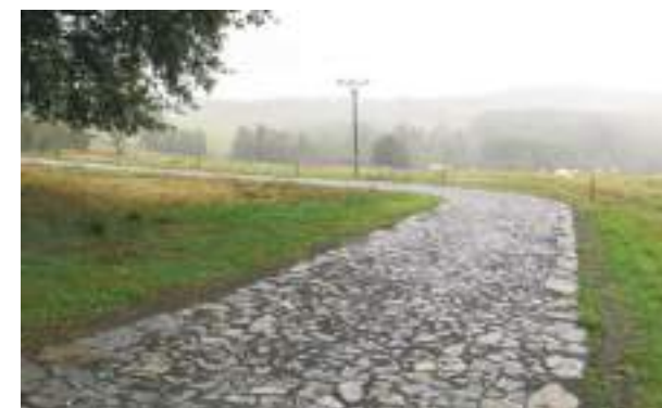
Obrázek 17: Realizace HPC1 a 1 (hlavní polní cesta) a VPC5 (vedlejší polní cesta) v k.ú. Krásno nad Teplou, Pobočka Sokolov (nyní Karlovy Vary), KPÚ pro Karlovarský kraj. Rok realizace 2019, náklady na realizaci 16 871 492 Kč, zdroj financování PRV 2014 – 2020.
