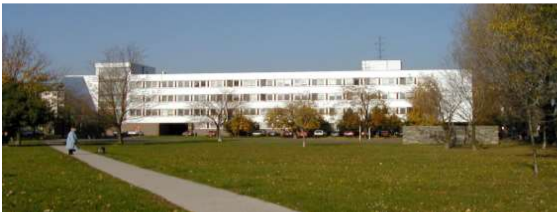
Obr. 40 Bočný pohľad na budovu GKÚ okolo roku 2000 [74]
