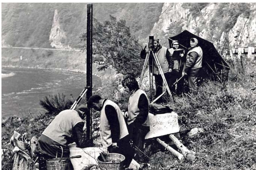
Obr. 6 Ukážka nivelačného merania pracovníkov GÚ, n. p. na ZNB Strečno [33]
