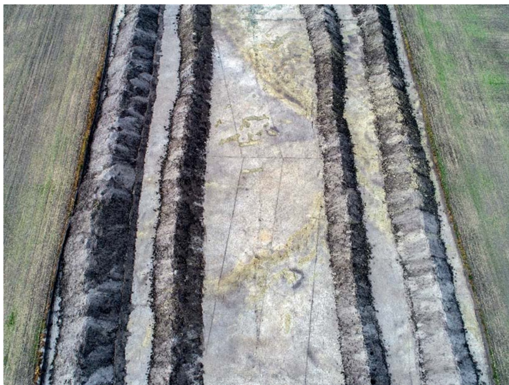
Obr. 1 Odhalené stavby meliorací po provedení skřívky před výstavbou dálniční komunikace
